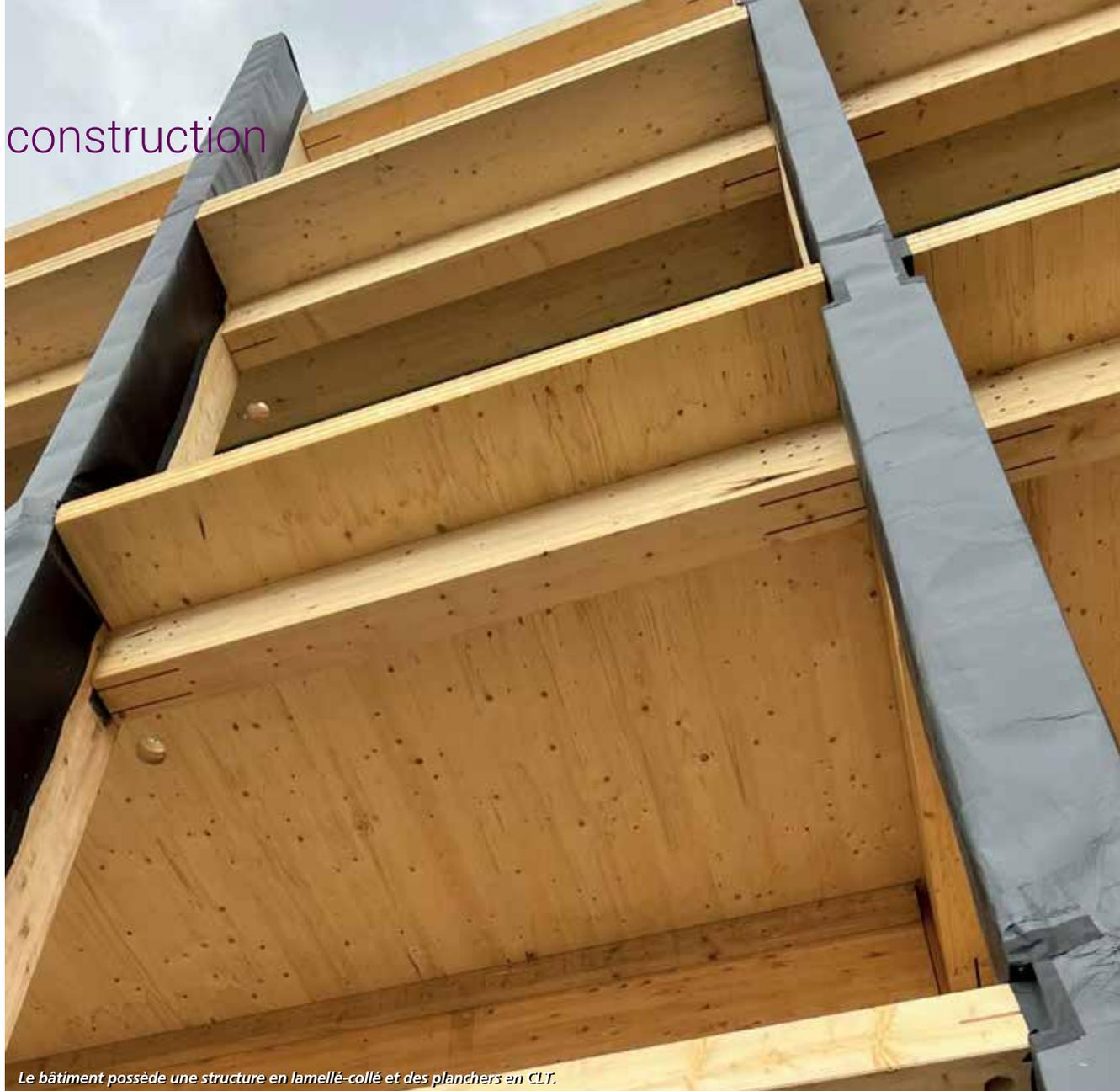
Le bâtiment possède une structure en lamellé-collé et des planchers en CLT.
