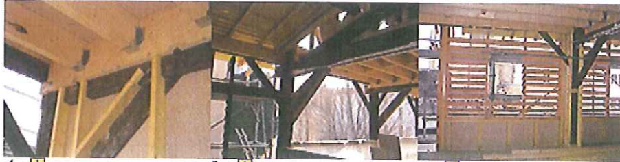
4 Les solives en Lamibois, et la charpente d'origine
