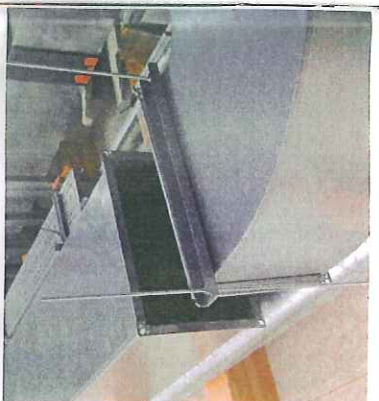
Des gaines de ventilation aux dimensions impressionnantes assurent la distribution de l'air neuf et la récupération de l'air vicié dont la chaleur est récupérée - c'est le dit « double flux ». Entre les poutres, les panneaux acoustiques, et entre les étages, une chape flottante de plusieurs épaisseurs, pour une bonne ambiance acoustique intérieure.
